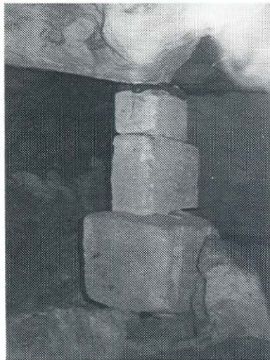
Figuur 5. De uit mergelblokken opgestapelde steun- pilaar.
