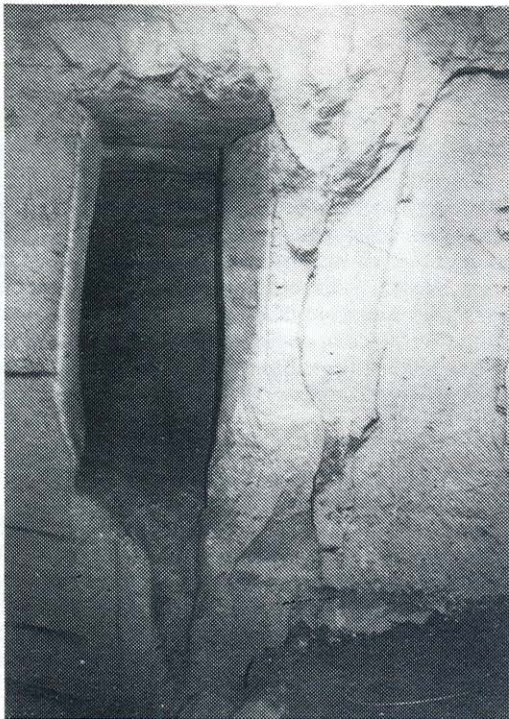
Figuur 3. Plaats waar vanaf de instorting het hoger gelegen tweede stelsel kan worden bereikt.
