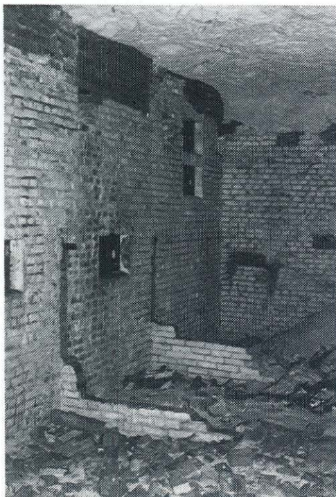
Een van de kamers in de transformator- ruimte.
