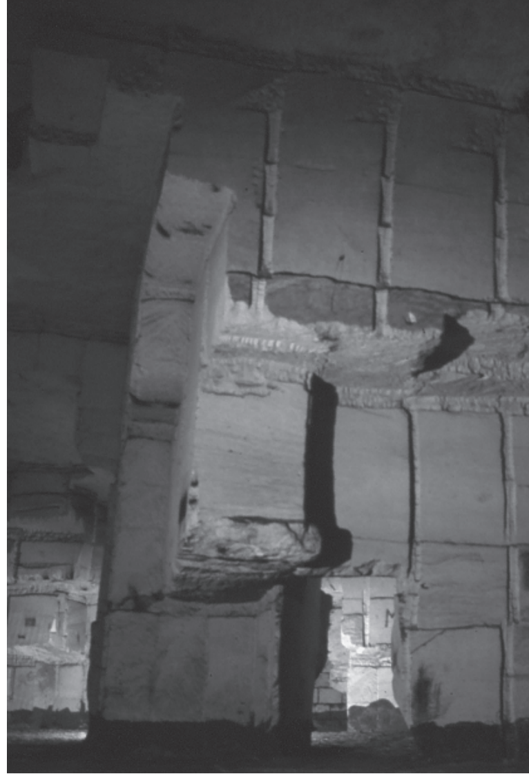
Afb. 6 Roofbouw in pilaar 2
