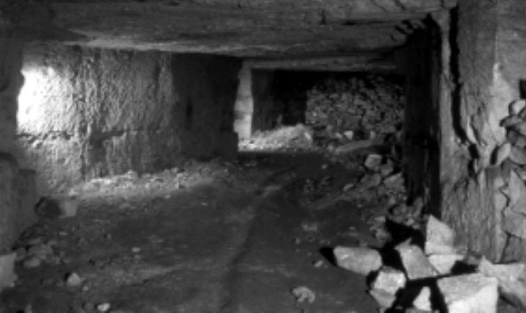
Abb. 12 : Karrenweg durch die Steinbrüche. Rechts: Trockenmauern, hinter denen der Schutt gestapelt wurde.
