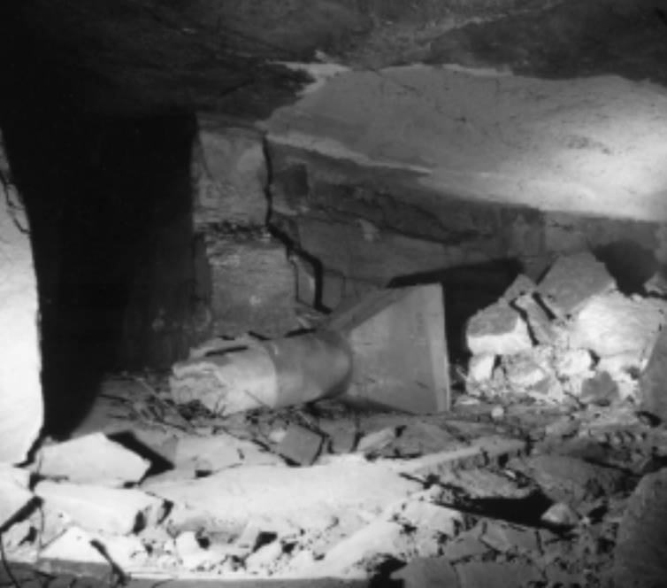
Abb. 5: Die von der Organisation Todt 1944 errichtete Betonsäule wurde 1947 von den Alliierten gesprengt. Helle Flächen zeigen, wo Deckenteile herabgestürzt sind. Höhe der Grube ca. 7 Meter.
