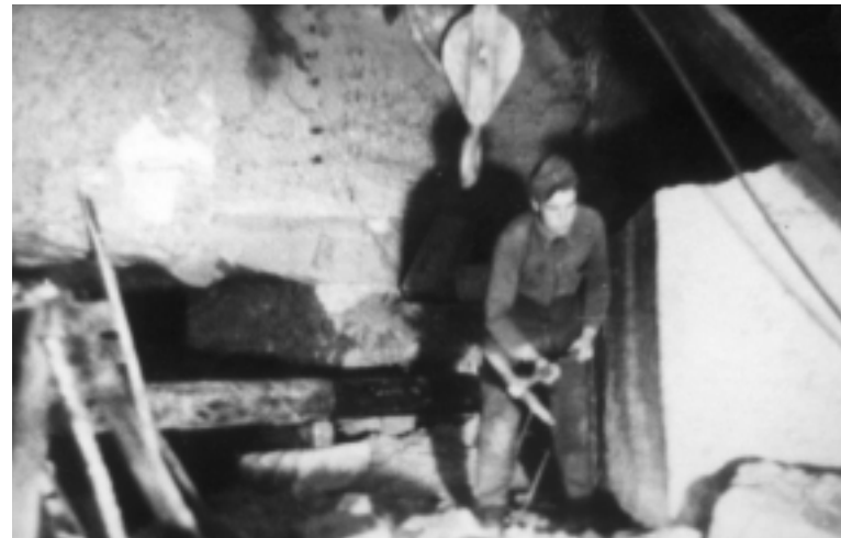
Abb. 10 : Georg Rings beim Zurichten eines frisch gebrochenen Blocks. Darüber Kran mit Flaschenzug. Aufnahme 1948.
