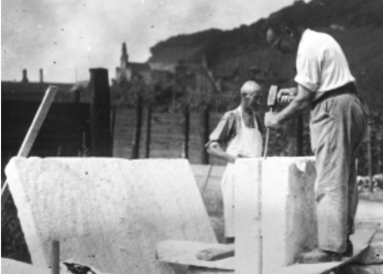
Abb. 14 : Th. Rings beim Scheiden eines Blocks zu Ofenplatten. Aufnahme 1948.
