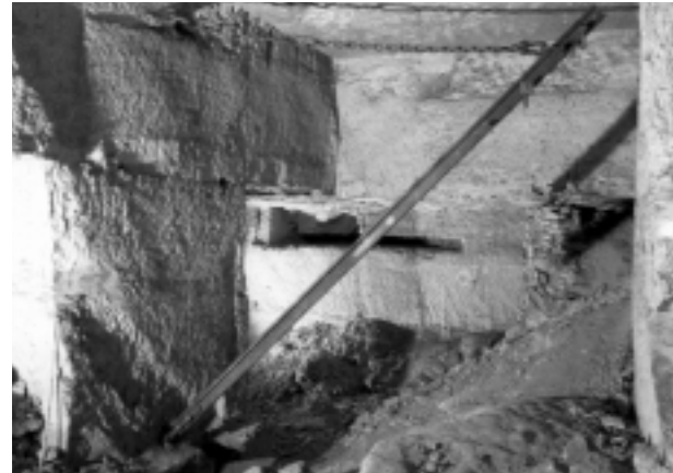
Abb. 3 : Kappständer zum Heben der Steine
