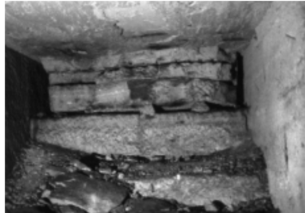
Abb. 8: Gerade abgelöster "Pappendeckel". Etwas unterhalb der Decke ist noch der Verlauf der Keilreihe zu erkennen, links und rechts die senkrechten Fuhren. Zwei Steine verhindern das vollständige Absinken des Blocks, damit er besser herausgehoben werden kann. Breite des Gangs: 4 Meter.
