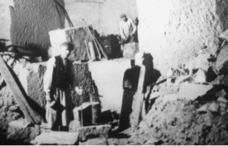
Abb. 11 : Werkplatz unter Tage. Unten ein Ofenbauer beim Zurichten von Gewölbesteinen. Oben Abbau von Böcken. Dabei arbeitete sich man in Stufen vorwärts.
