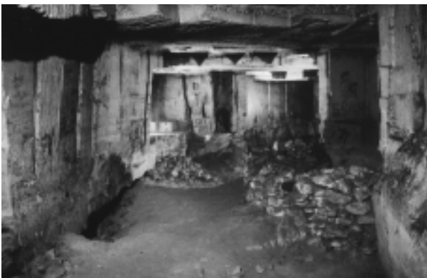
Het gedeelte in de Vallenberg te Sibbe, waar veertiende eeuws aardewerk werd gevonden. De ontginningswijze is dezelfde als de oude ontginningsniveau's in de Gemeentegrot in Valkenburg. Er werd hier ontgonnen via de "waaierstechniek".
