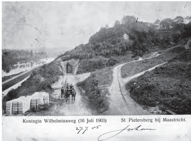
FIGUUR 4: Gezicht op de ruïne Lichtenberg. Op de voorgrond is het naar rechts stijgende smal-spoor te zien met links, klaar voor het transport, een stapel mergelblokken. Ter hoogte van de mergelblokken was ook stortplaats voor de losse mergel. In het midden is de Wilhelminaweg met haar beroemde tunnel te zien. Het pad dat halverwege de afbeelding naar rechts verdwijnt is de zogenaamde Ezelenweg. Dit pad liep naar de hoeve Lichtenberg (collectie John Hageman).
