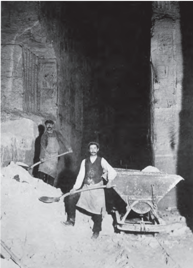
FIGUUR 3: Ondergrondse mergelontginning. Deze afbeelding is waarschijnlijk op het einde van de IJzeren weg gemaakt (uit: De Sint Pietersberg, Maastrichts silhouet).
