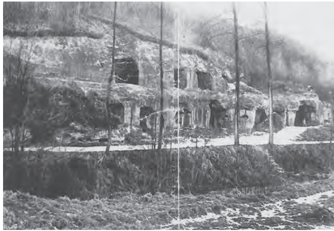
FIGUUR 7: Ontginning op twee niveaus.
