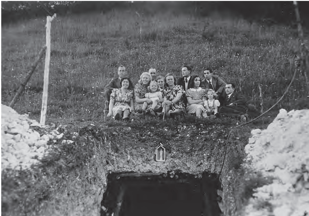
FIGUUR 18: Boven de ingang. Duidelijk is de elektrische toevoerkabel te zien
