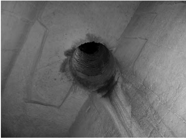
AFBEELDING 1: Uitmonding van de oude schacht, op negen meter hoogte in het plafond
