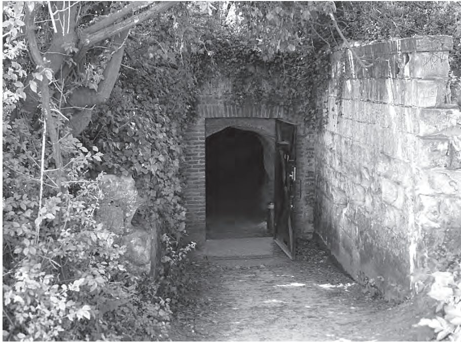
AFBEELDING 2: De huidige toegangsdeur
