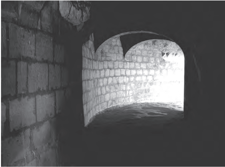
AFBEELDING 6: Muur met steunbogen
