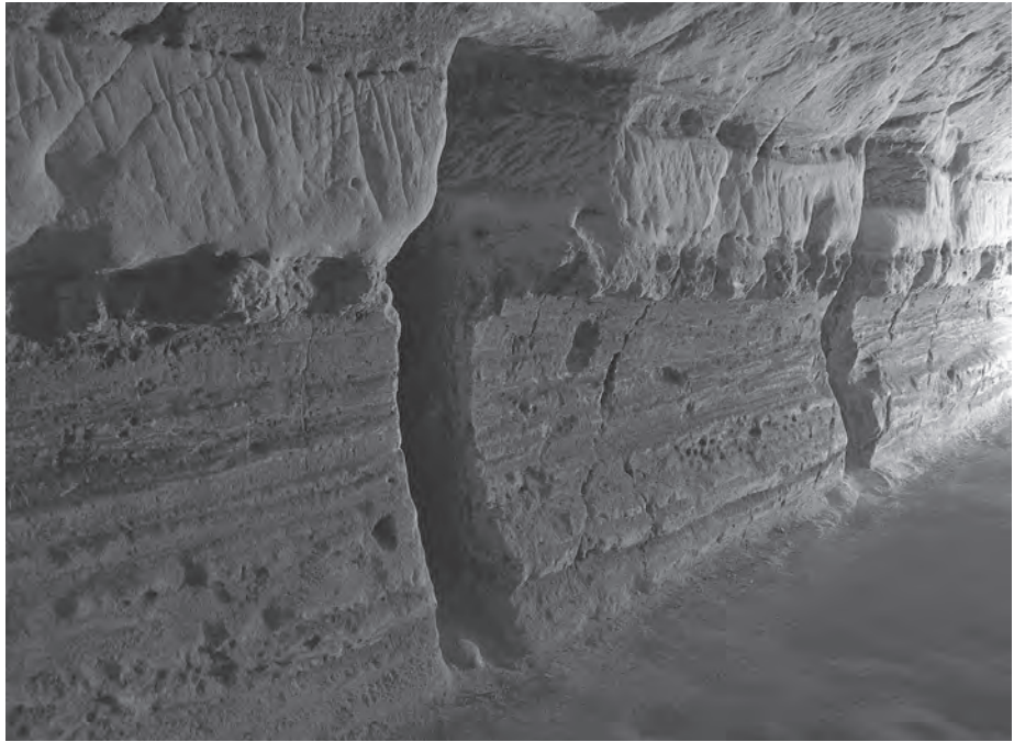
AFBEELDING 5: Verticale sleuven ten behoeve van versperring
