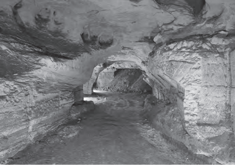
AFBEELDING 7: De aan/afvoerroute, met duidelijk boogvormige verhoging van het plafond. De verkantingen laten de oorspronkelijke hoogte van het plafond zien. Links zijn de hoge karrensporen zichtbaar
