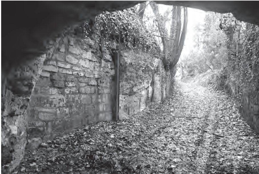
AFBEELDING 12: De stijgende karrenweg gezien vanuit de tegenwoordige ingang van de Lacroixberg. Achter de gemetselde muur ligt een ingestorte gang van de Lacroixberg, die voor de ingang doorliep naar rechts en daar nu toegang biedt tot de Grote Berg. Aan de linkerkant (rechts van de gemetselde muur) ziet men nog blokbreeksporen; een gangrestant van de Lacroixberg (foto Peter Jennekens)
