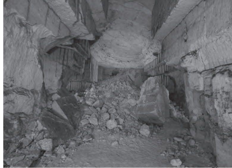
AFBEELDING 2: Links een 3D beeld van een ingestorte pilaar in groeve Grootberg, rechts een foto van dezelfde locatie (foto: Roger Magnee). Blokvormen in pilaren en brokstokken zijn zichtbaar en komen overeen met deze in de foto. De lijn is de afgelegde looproute tijdens het laserscannen.
