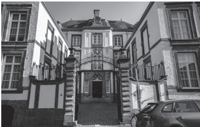
AFBEELDING 4: Rondom het Henric van Veldekeplein liggen een aantal kanunnikenhuizen met de status van rijksmonument. Het grootste en indrukwekkendste is deze proostenwoning (ca. 1750). In dit stadspaleis woonde de proost van het Sint-Servaaskapittel. Foto: Rob Heckers.
