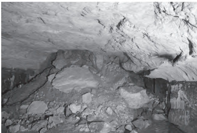
AFBEELDING 17: Afsluiting gang door instorting
