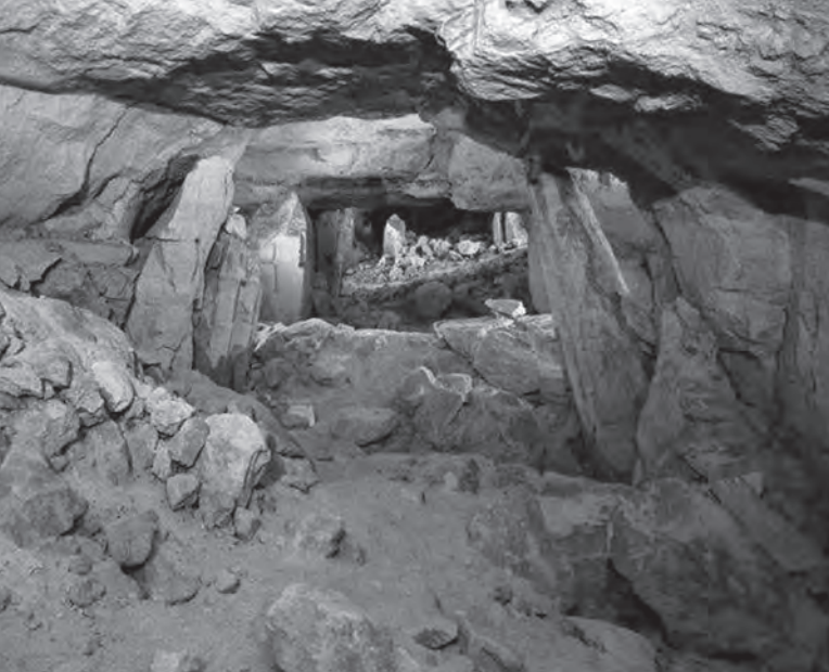
AFBEELDING 19: Gang met afgesprongen schollen
