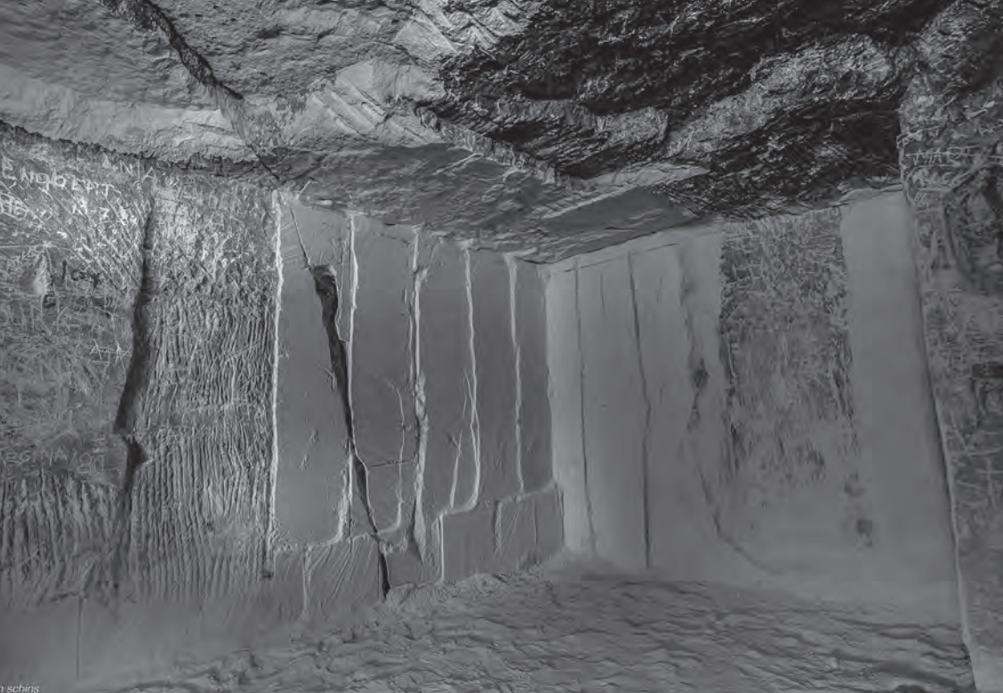
AFBEELDING 4: Sporen van stootbeitel en kettingzaag in de vergrootte 'achterste kamer'
