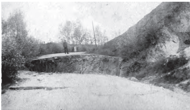
AFBEELDING 12: Verzakking van de weg naar Wolder
