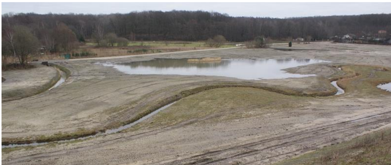
Nieuwe loop Wilderbeek bij Egypte, net na aanleg in 2012. Inmiddels is dit al flink begroeid. Linksboven moet de Zijtak Wilderbeek nog aangesloten worden
