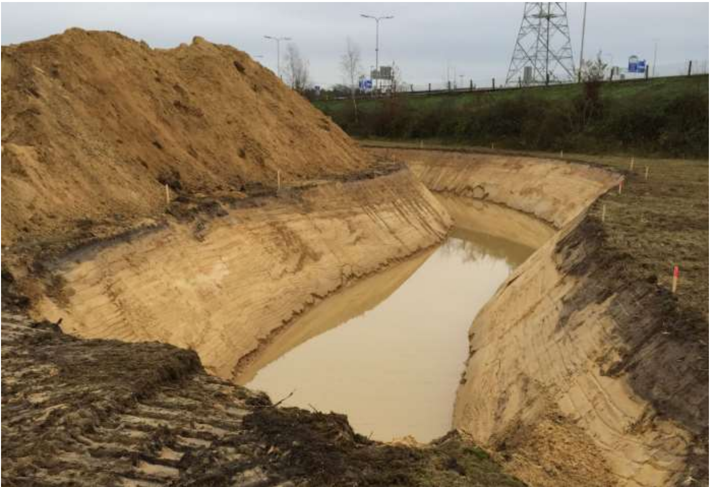
Nieuwe, meanderende loop Everlosebeek benedenstrooms van het Koelbroek, bij de oprit naar de A73
