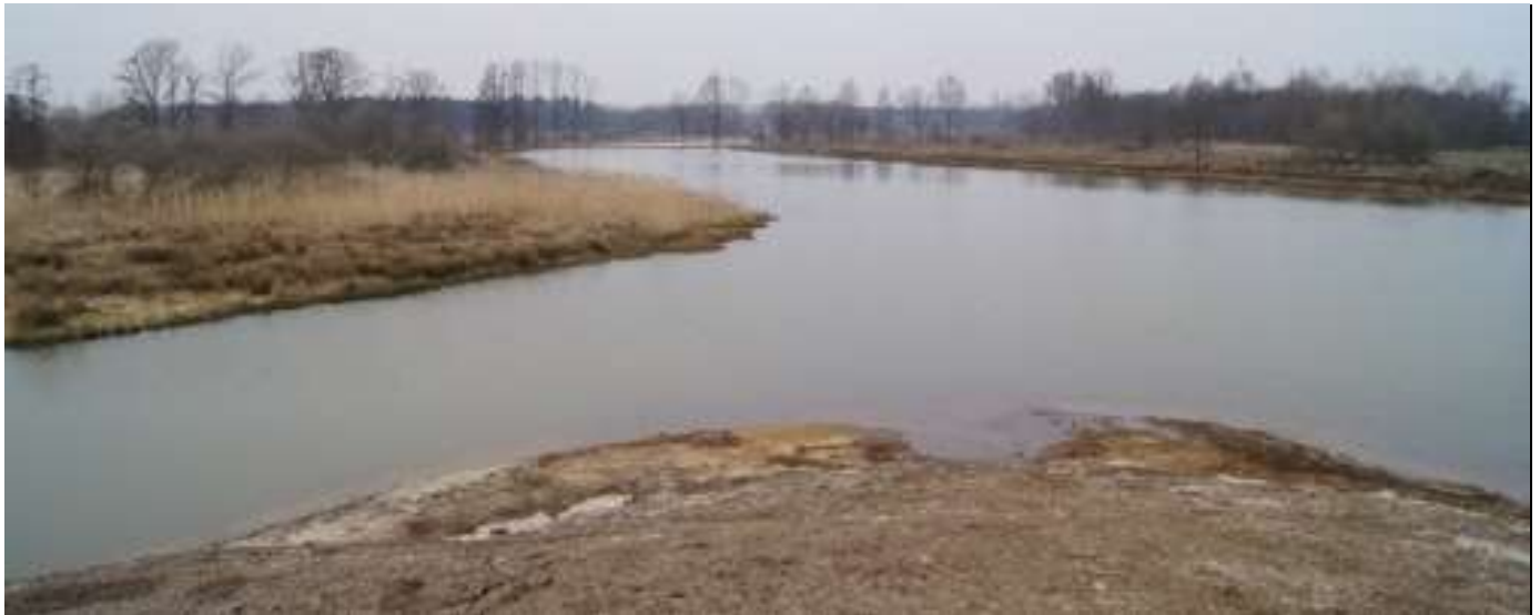
Swolgenderbroek Klimaatgeul net na aanleg
