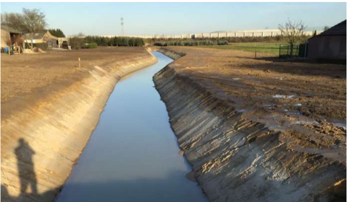
Nieuwe loop van de Everlosebeek oostelijk van de Geliskensdijk. Helaas is er een knik in de loop door de onvoltooide Noordervaart aangebracht. Hierdoor wordt het rechte kanaalkarakter verstoord.
