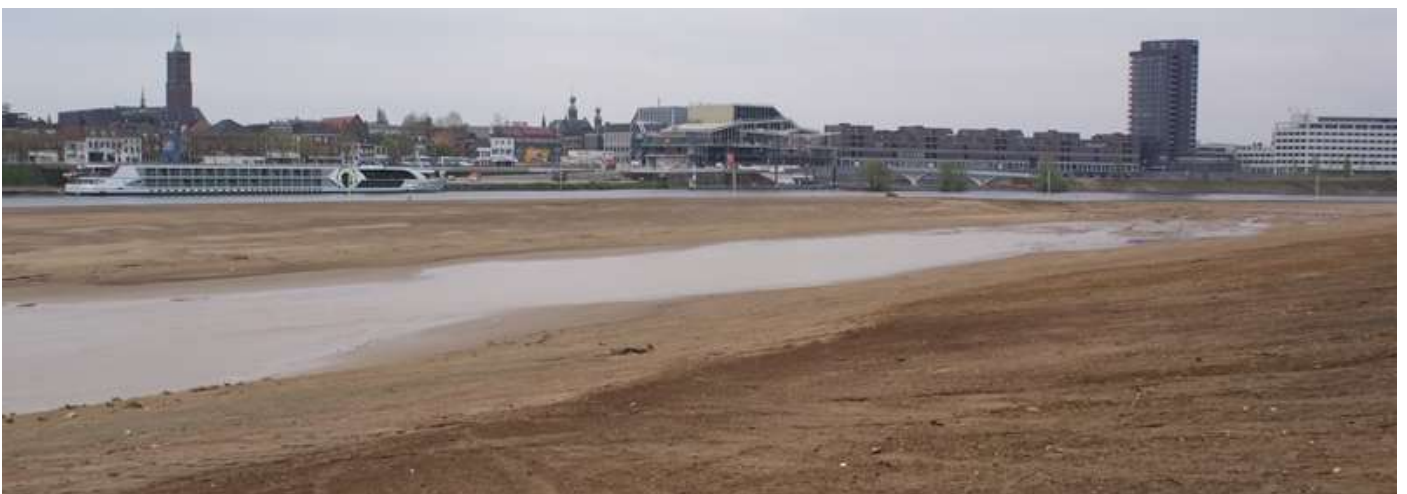
Nevengeul Raaijweiden net na aanleg
