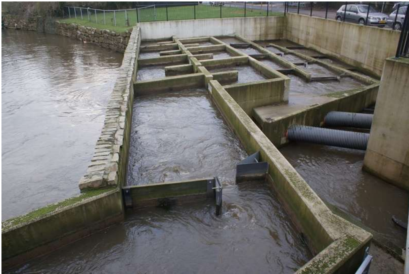
Vispassage in de Roer bij de ECI-centrale in Roermond
