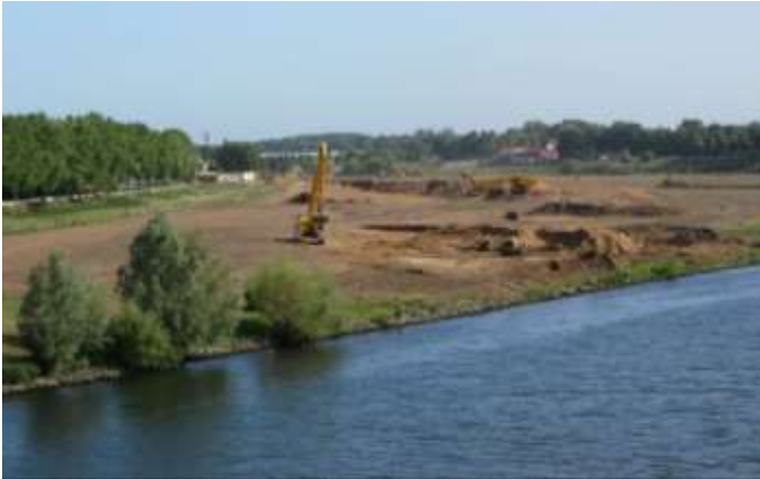
Aanleg nevengeul in 2011
